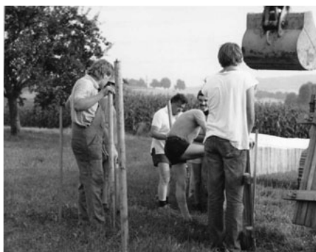
1981 Bretterzaun ersetzt Maschendrahtzaun
