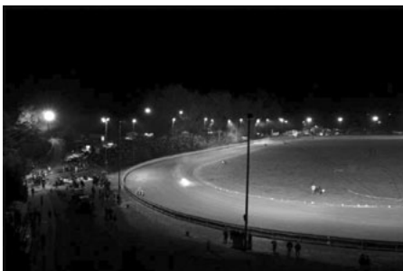
Flutlichtrennen - neue Masten 2006
